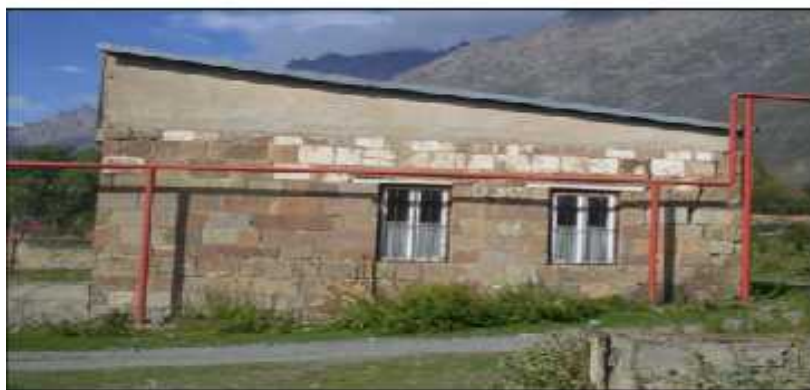
კახსნიკეთი ფასადი / South Facade
