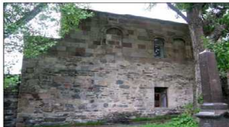
სამხრეთი ფასადი / South Facade
